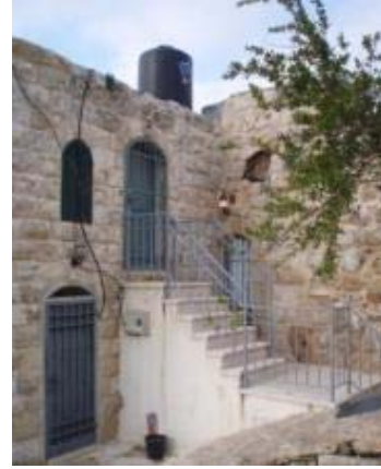
الشكل(4-51): المدخل الجانبي لمضافة القرية قبل الترميم
