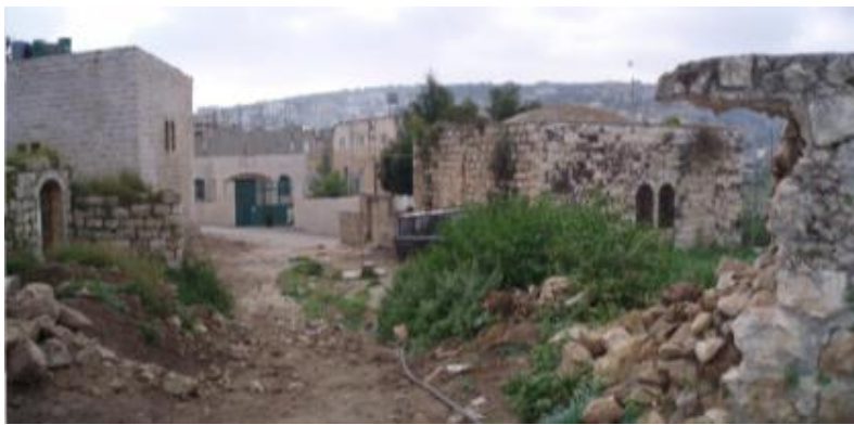
الشكل (5-90): صورة من الجانب الغربي تظهر المضافة والأرض المجاورة لها والملبئة بالحشائش والتي سيتم استملاكها وضمها لفراغ الساحة - المصدر: الباحثة
