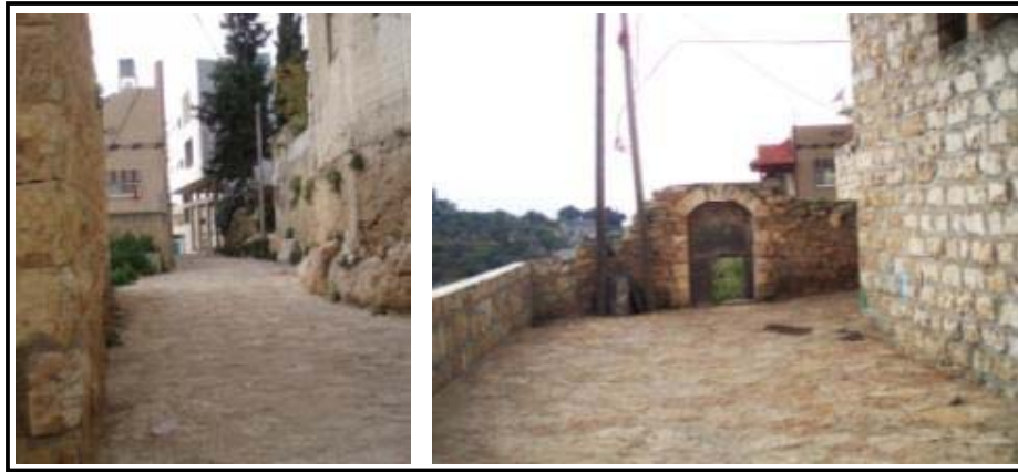
الشكل (5-108): صور للطريق القديمة بعد رصفها وتبليطها ببلاط حجري-المصدر الباحثة
