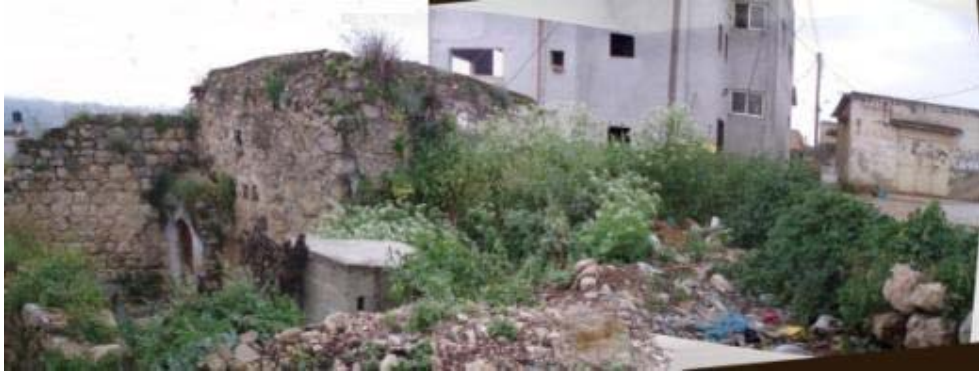
الشكل (4-46): صورة تبين حد الساحة من الجهة الجنوبية حيث بناية حديثة من 4 طوابق أقيمت بعد هدم
